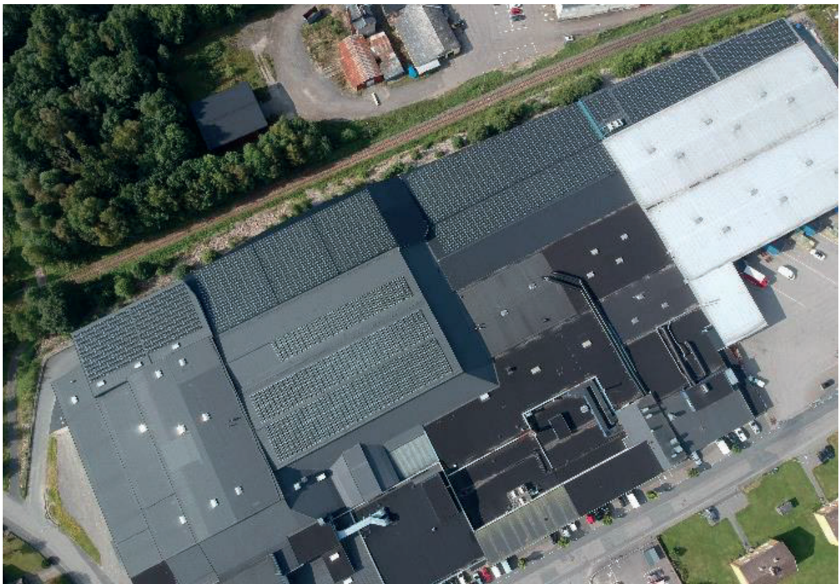
Flygfoto över våra nyinstallerade solceller
